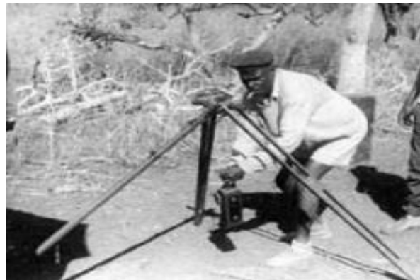
colocação do peso tensor
