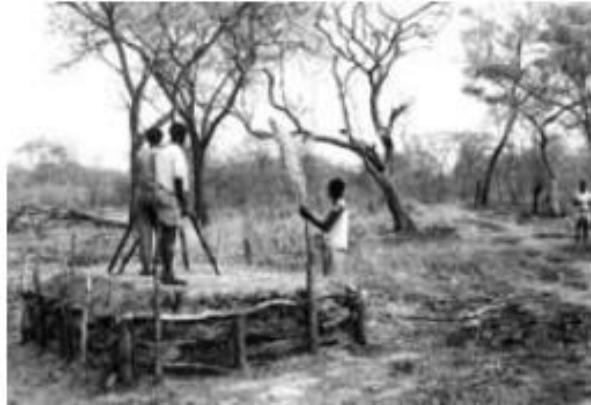
estruturas para atenuar a inclinação do terreno e ultrapassar uma depressão
