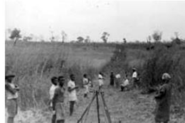
colocação dos tripés ao longo da base
