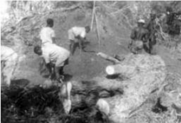
remoção de troncos ao longo do alinhamento
