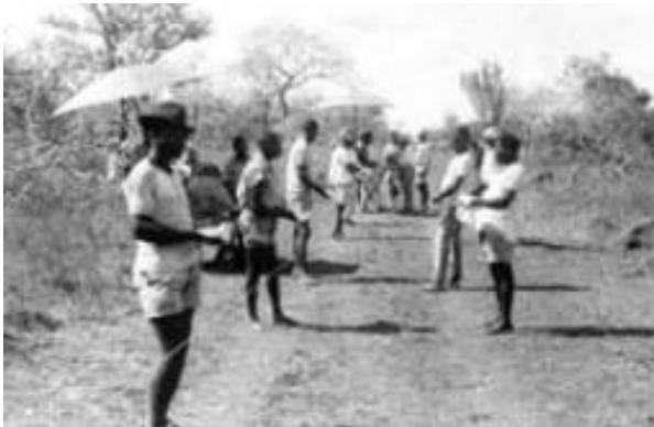
colocação do fio sobre os tripés
