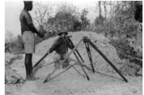
nivelamento entre tripés
